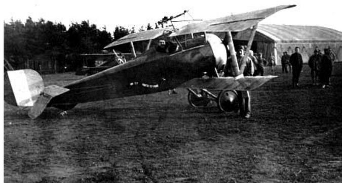
**Nieuport XVII de l'escadrille N 38 - Cet avion est équipé d'un montage Moreau pour la mitrailleuse Lewis de l'aile supérieure**
